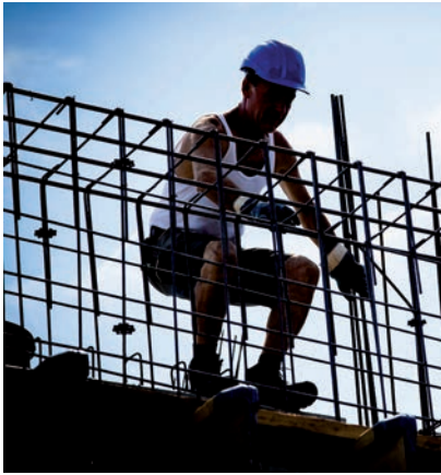
Eisenflechter beim Wohnungsneubau: Da mit trotz steigender Baupreise mehr bezahlbarer Wohnraum in der Region entsteht, fordert die IG BAU Oderland zusätzliche Anstrengungen von der Politik.
