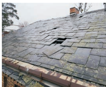
Zerfallerscheinungen: Um die Gebäudesubstanz zu erhalten wurde zunächst die Dachsanierung angegangen.
