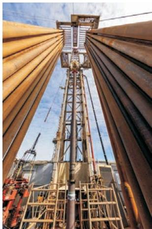
zwischen dem eingebauten Rohrin-Rohr-System und dem Gebirge auf Dichtheit getestet und den Nachweis erbracht, dass die Bohrung bei den notwendigen Drücken dicht ist. Der hausgroße Hohlraum befindet sich in einem unterirdischen Salzstock. Diese Steinsalzschiefer unter dem Speichergelände in Rüdersdorf, in der EWE bereits zwei große Kavernenspeicher gebaut hat, beginnt in etwa 600 Metern Tiefe und reicht bis auf 3.200 Meter unter die Erdoberfläche.
