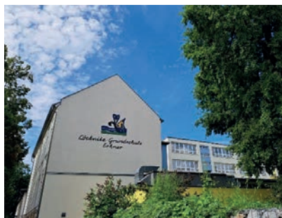
Wir wollen die Erweiterung der Löcknitzgrundschule in Massivbauweise für 7,4 Millionen Euro
